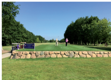
Erneuerung des Abschlags 2014
